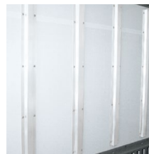
⑦ アルミエアリブ (断面ハット型)
