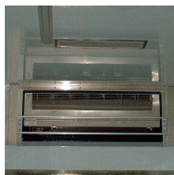
㉞ 冷凍機プロテクター
