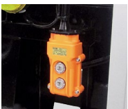
室外操作スイッチ
