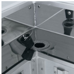
㉔ 床水抜き穴(ゴム栓付)
