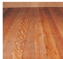
㉓ アピトンフローリングフロア
